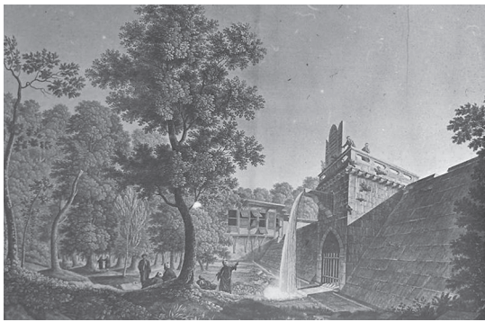
図35 給水施設の建設（ダム）
