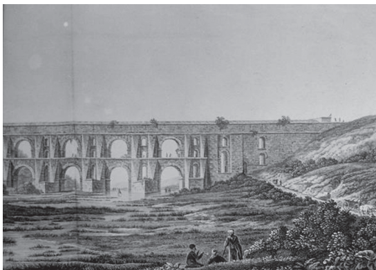
図36 給水施設の建設（水道橋）
